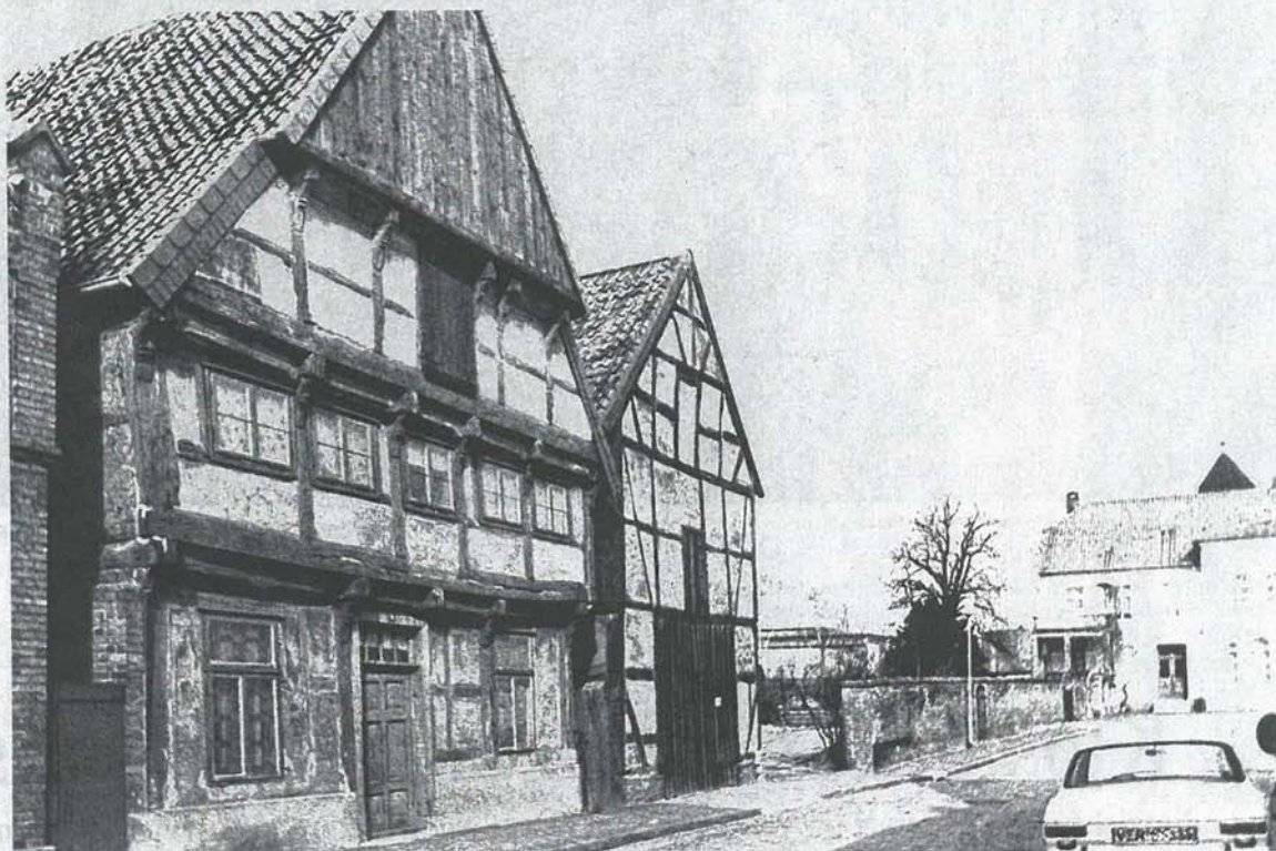
Historische Aufnahme aus besseren Zeiten: So sahen die Fachwerkhäuser am Norderstädtischen Markt in den 1970er-Jahren aus. Eigentümerin Doris Focke will das Ensemble bald wieder in einen vergleichbaren Zustand versetzen. FOTO: FR
