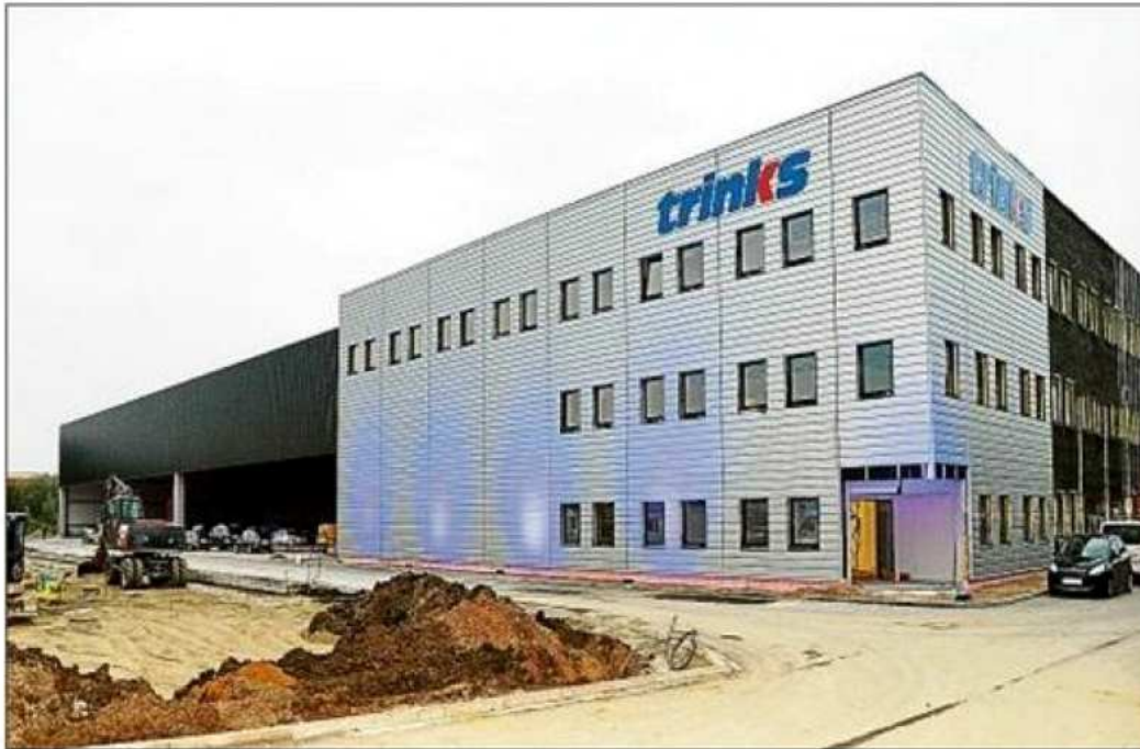
Das neue Logistikzentrum der Firma Trinks Süd GmbH in der Fraunhoferstraße 10 in der Hasenheide geht seiner Vollendung entgegen
