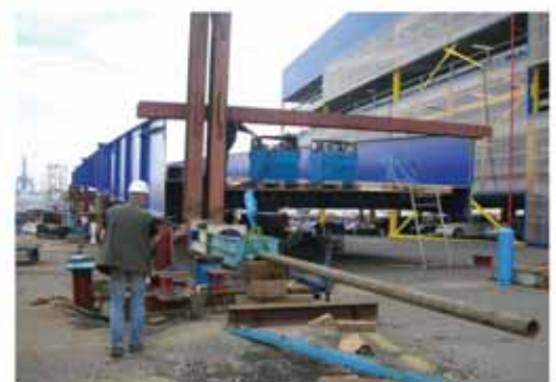
14 Montage mit Vorschubeinrichtung © Fritz-Dieter Tollé
