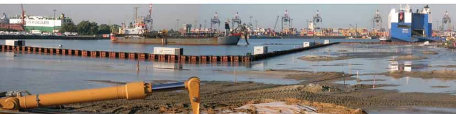
4 Verfüllung am Osthafen © Fritz-Dieter Tollé
