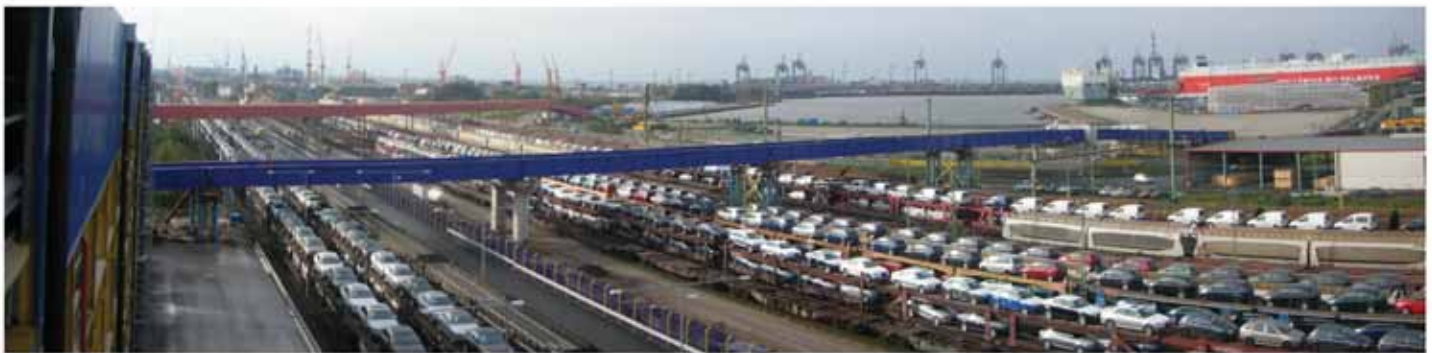
17 Realisiertes Verbindungsbauwerk © Fritz-Dieter Tollé
