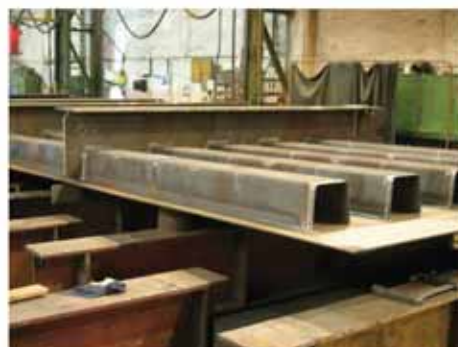
13 Werksfertigung der orthotropen Platte © Fritz-Dieter Tollé
