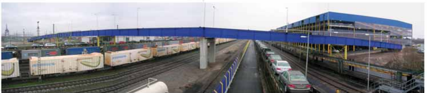
18 Brückenansicht von Süden © Fritz-Dieter Tollé
