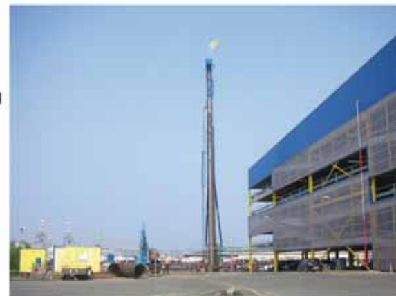
3 Einbringen der Ort betonrammpfähle © Fritz-Dieter Tollé
