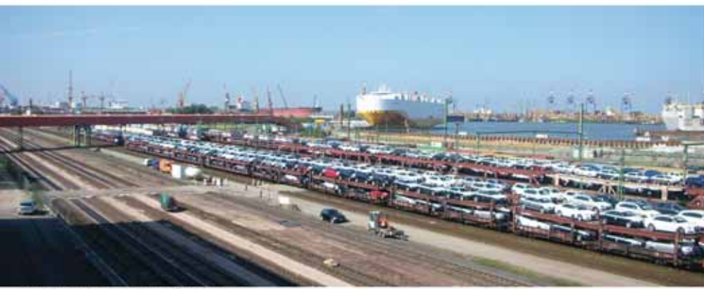
2 Gleisquerung im Bahnhofsbereich © Fritz-Dieter Tollé
