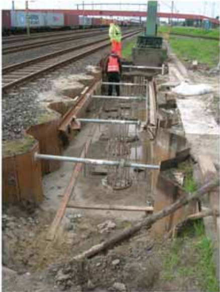
10 Herstellung der Pfahlkopfplatte © Fritz-Dieter Tollé
