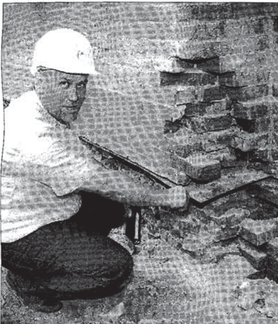
Projektleiter Uwe Bade demonstriert einen wichtigen Bestandteil der Sanierung: Die Wände der Altgebäude wurden waagrecht aufgeschnitten, damit Edelstahlbleche hineingeschoben werden konnten. Sie sollen vor aufsteigender Feuchtigkeit schützen. Rechts die Baugrube der Tiefgarage unter dem künftigen SB-Warenmarkt der Edeka. Sie soll etwa 400 Fahrzeuge aufnehmen. Fotos (4): Manfred Below
