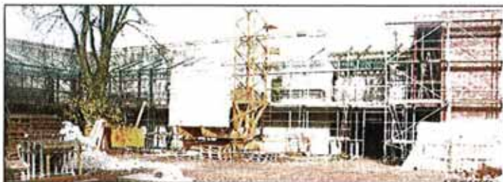
Der Neubau zwischen Turnhalle und Fachtrakt.
